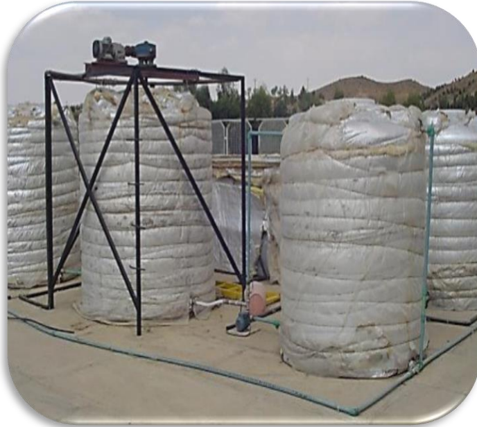
شکل ۲: تصویر اجرای سیستم ترکیبی هاضم بی‌هوازی با آهنگ بالا و لجن فعال
