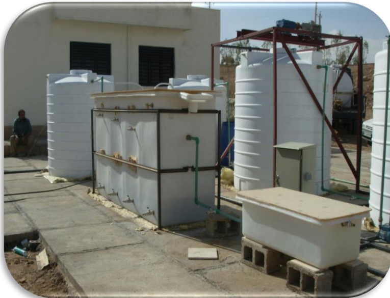
شکل ۱۰: تصویر اجرای سیستم ترکیبی شامل ABR و لجن فعال
