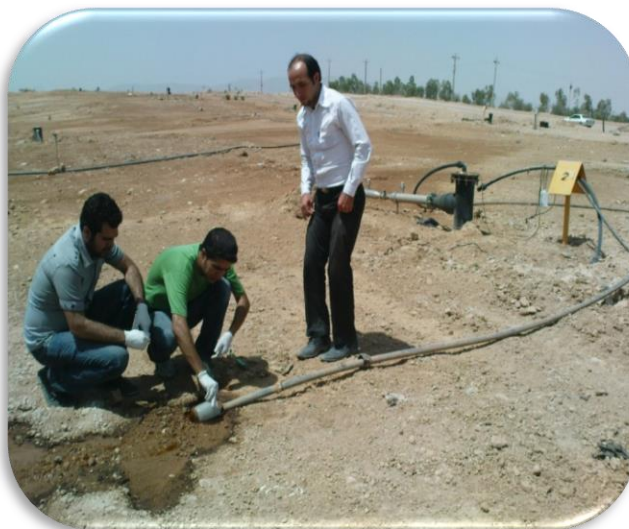
شکل ۲۸: نمونه برداری از شیرابه خروجی چاهک شیرابه
