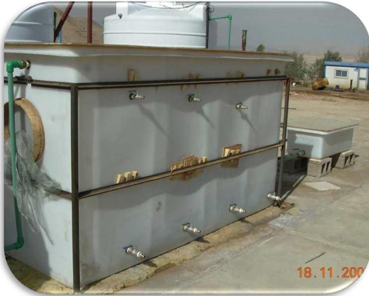
شکل ۹: تصویر اجرای سیستم ترکیبی شامل ABR و لجن فعال
