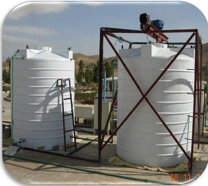
شکل ۶: تصویر اجرای سیستم ترکیبی هاضم بی‌هوازی با آهنگ بالا و لجن فعال
