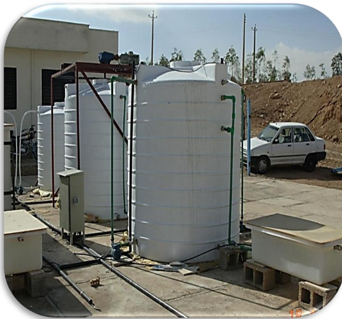
شکل ۴: تصویر اجرای سیستم ترکیبی هاضم بی‌هوازی با آهنگ بالا و لجن فعال
