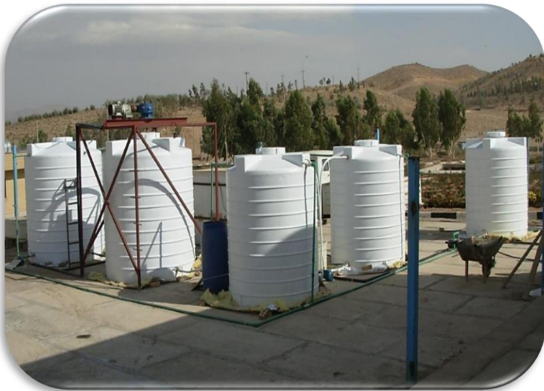
شکل ۷: تصویر اجرای سیستم ترکیبی هاضم بی‌هوازی با آهنگ بالا و لجن فعال
