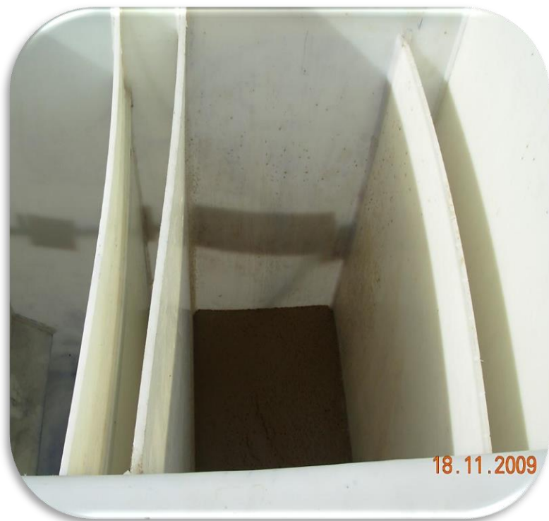
شکل ۱۱: تصویر اجرای سیستم ترکیبی شامل ABR و لجن فعال
