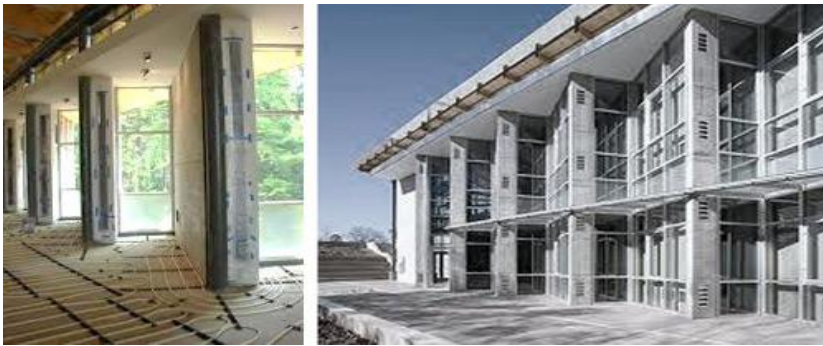
شکل ۵: استفاده از تکنولوژی دیوار ترومپ در ساختمان
